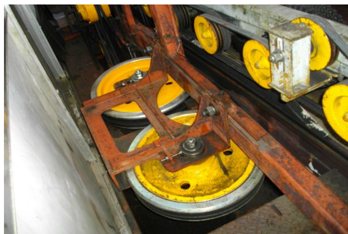
押送拡張輪整備
